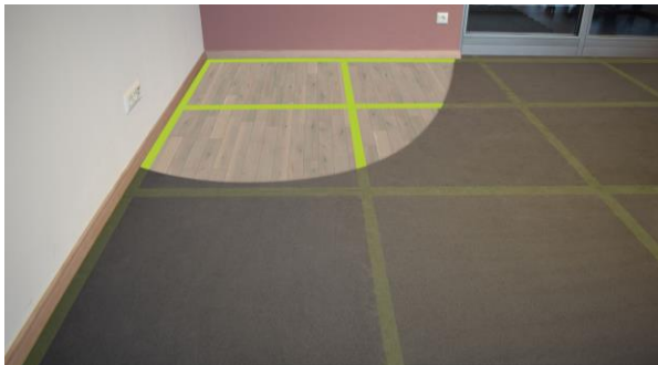
Bei 6mm : Verklebung am Randbereich und im Bereich der Verzahnung
