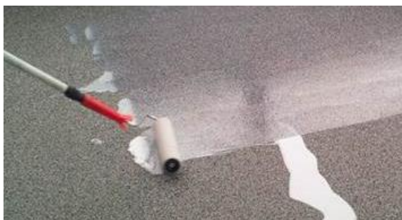
Auftragen der Versiegelung
